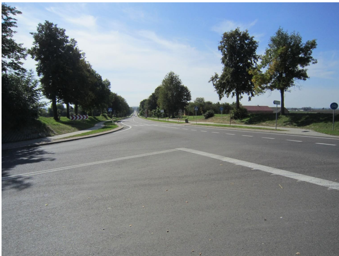
Fot. 1. Skrzyżowanie DW 844 z DP 3407 L (ul. Dziekanowska)
