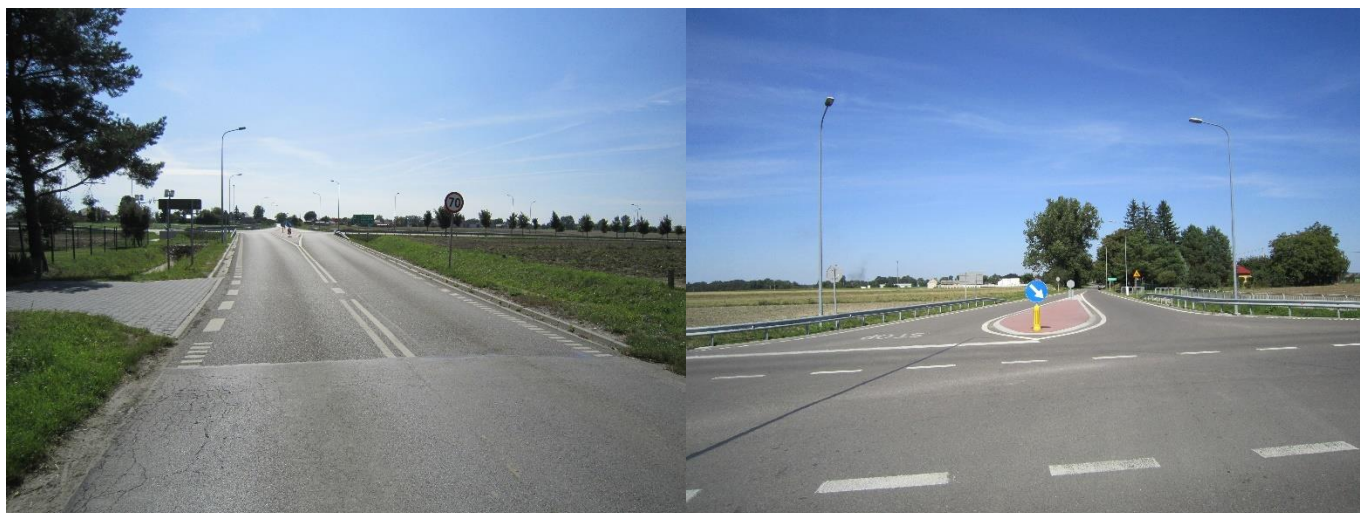
Fot. 4 i 5. Skrzyżowanie skanalizowane DP 3411L z DK-74.
